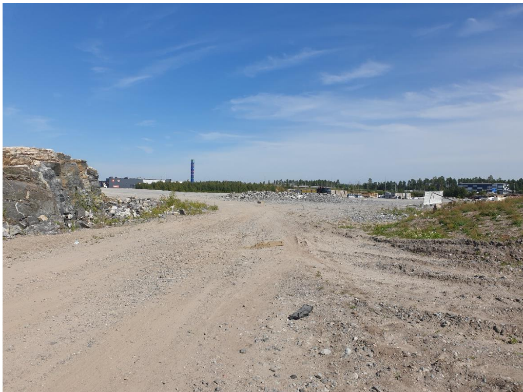
Kuva 8. Suunnittelualueella oleva laaja rakennustyömaa.
