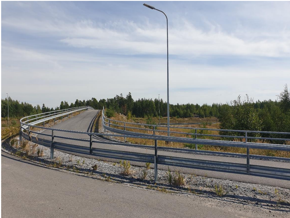
Kuva 6. Suunnittelualueelta valtatieen ylitse kulkeva jalankulkusilta, jonka kautta on merkitty viheryhteys yleiskaavassa.
