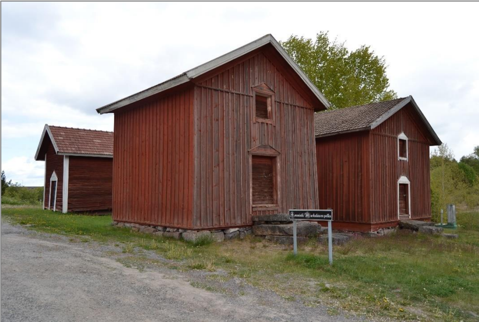
Kuva 36. Aittaryhmä kuvattuna lounaasta.
