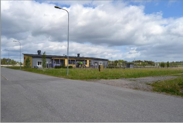
Kuva 10. Selvitysalueen pohjoispuoliselle peltoalueelle on rakennettu Pilke-päiväkodin päiväkotirakennus 2010-luvun lopulla.
