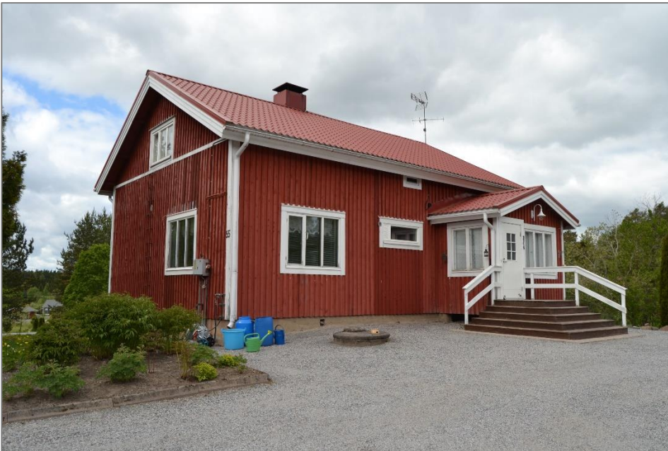
Kuva 20. Pirttimäen asuinrakennuksen itäisivu ja eteläpääty. Rakennus on puolitoistakerroksinen, harjakattoinen ja sen itäisivulla on harjakattoinen kuisti. Katteena on profiilipelti. Kuistin viereinen vaakaikkuna on tehty 2010-luvulla.
