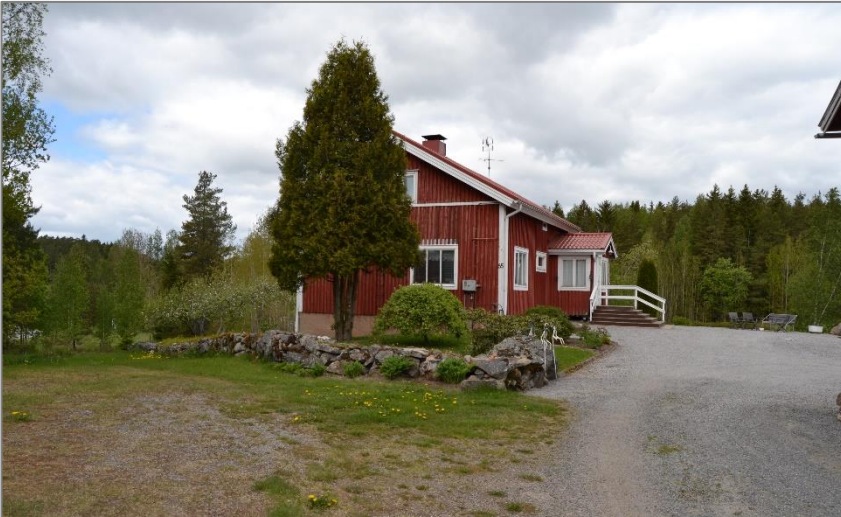
Kuva 22. Pirttimäen asuinrakennus kuvattuna etelän suunnasta. Pirttimäentien alkuperäinen linjaus on kulkenut kiviaidan edestä pihapiirin läpi.
