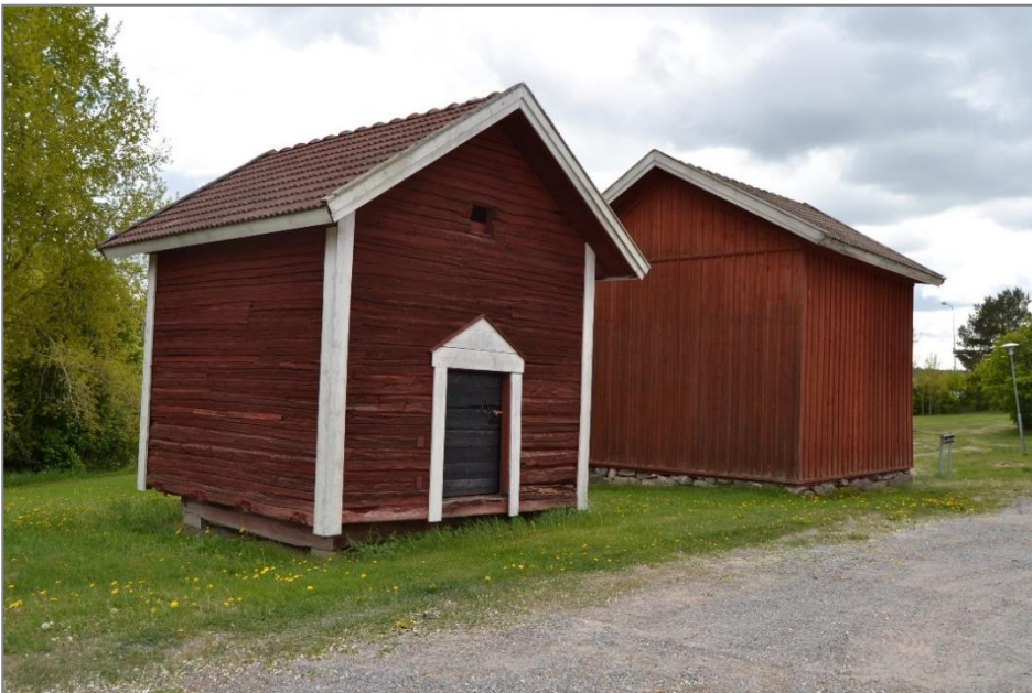
Kuva 37. Pohjoisimpana sijaitsevassa aitassa on puusokkeli.
