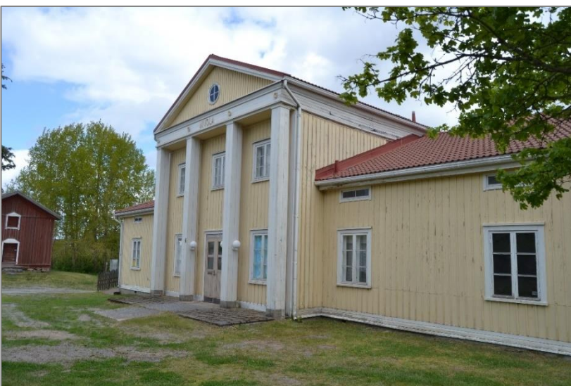
Kuva 30. Nivolan pääjulkisivua lännen puolelta. Ulkonevan poikkipäädyn pylväät ovat hieman erillään seinästä.
