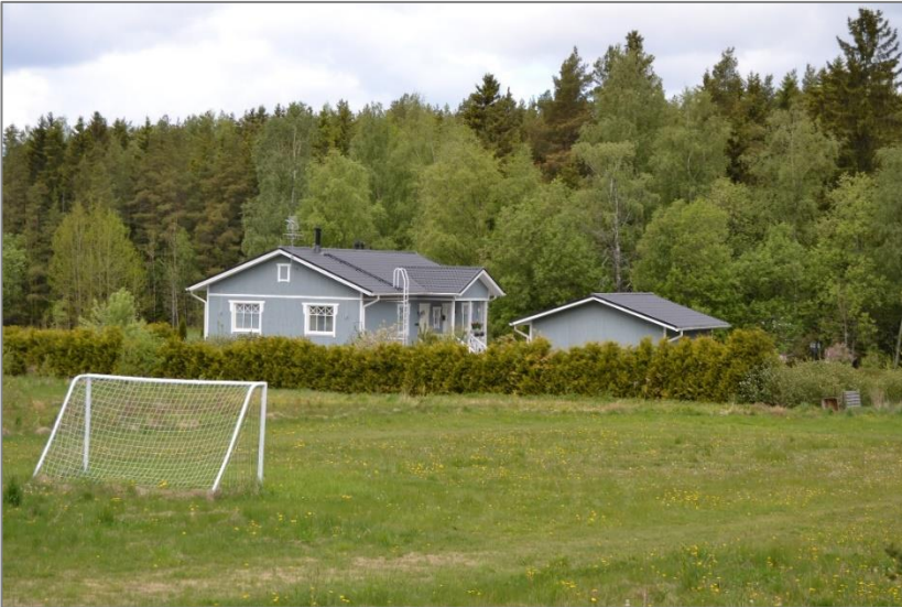
Kuva 18. Peltoalueen reunassa lähellä Pirttimäkeä sijaitseva vaalea, lautavuorattu omakotitalo, Pirttimäentie 45, on rakennettu vuosina 2013–2015.
