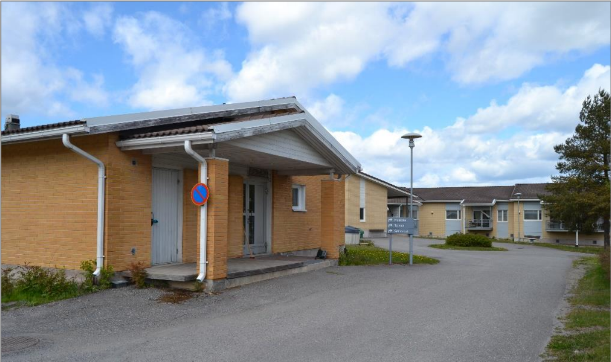
Kuva 57. Palvelukeskuksen länsisivua. Kuvassa vasemmalla vaiheen III pääty. Taustalla näkyy vaiheessa VI valmistunut rakennusosa.
