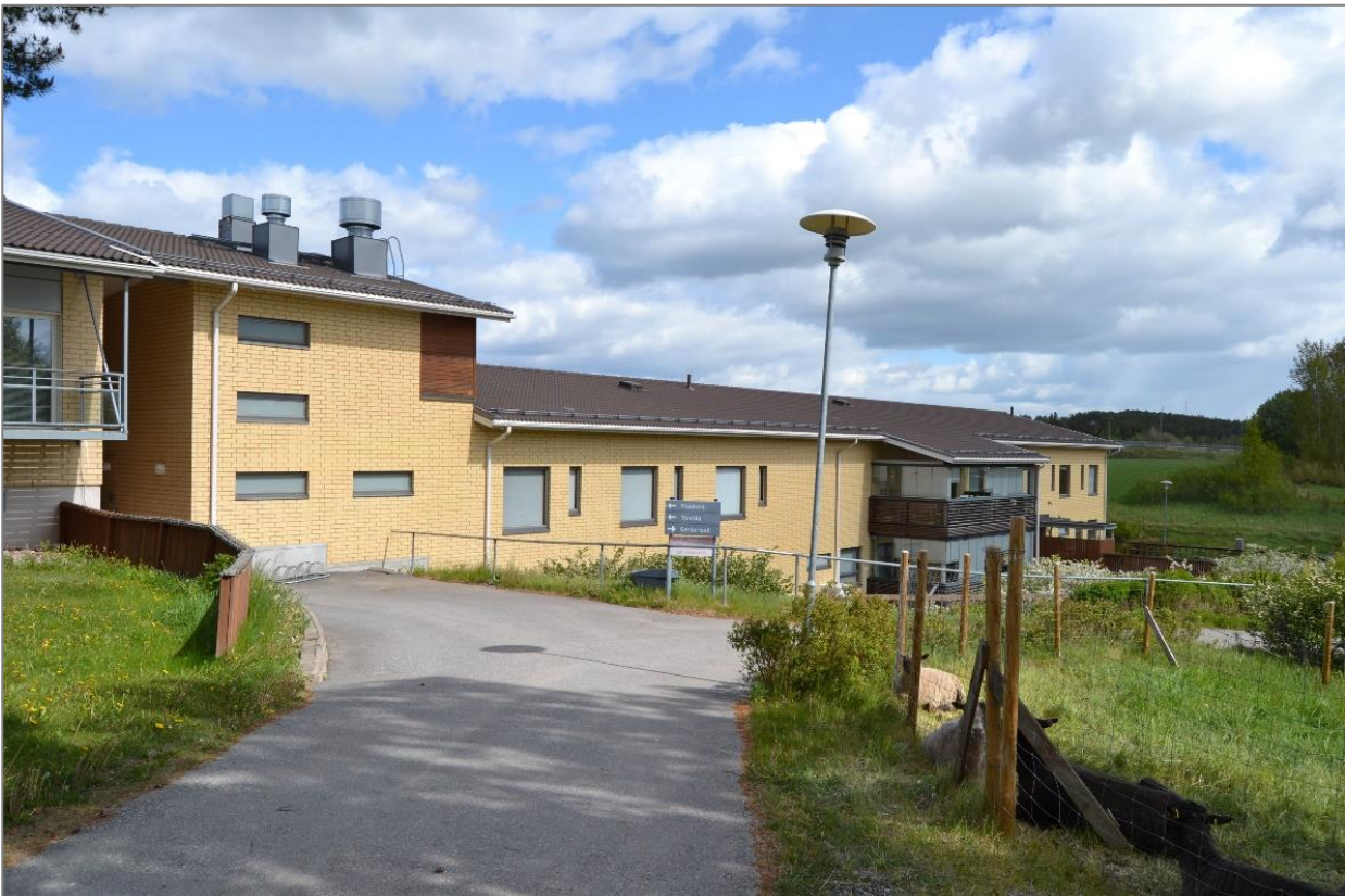
Kuva 56. Palvelukeskuksen itäsiipi eli 2009 valmistunut rakennusvaihe VII. Rakennusosa on jo tyyllisesti erilainen verrattuna 1990-luvun rakennusosiin, mutta sulautuu niihin massoittelemalla julkisivumateriaalien ansiosta.
