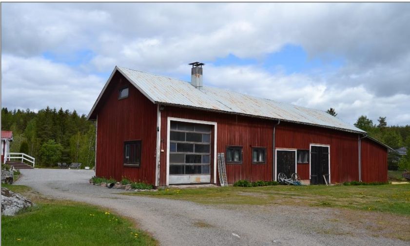
Kuva 23. Varasto- ja hallirakennus kuvattuna etelän suunnalta, Pirttimäentieltä päin. Kuvassa vasemmalla oleva pääty on rakennuksen alkuperäinen osa, johon on tehty myöhemmin muutoksia.
