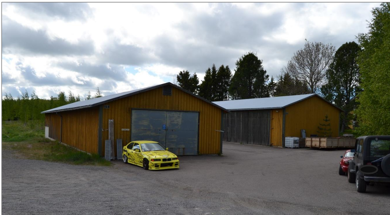
Kuva 44. Hallirakennukset kuvattuna Maskuntieltä. Kuvassa oikealla oleva halli on kalustosuoja, vasemmanpuoleinen valmistui alun perin kanalaksi.
