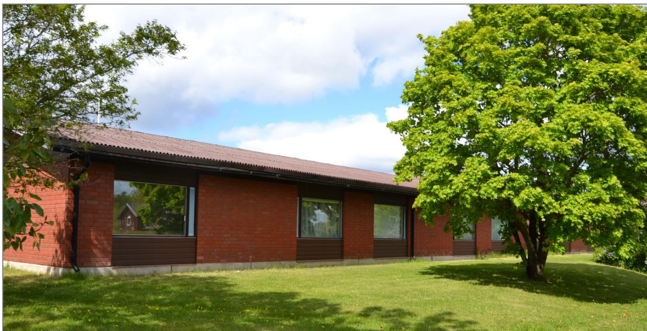
Kuva 49. Vanhusten asuinrivitalo kuvattuna Nivolantieltä, kuvaussuunta pohjoiseen.
