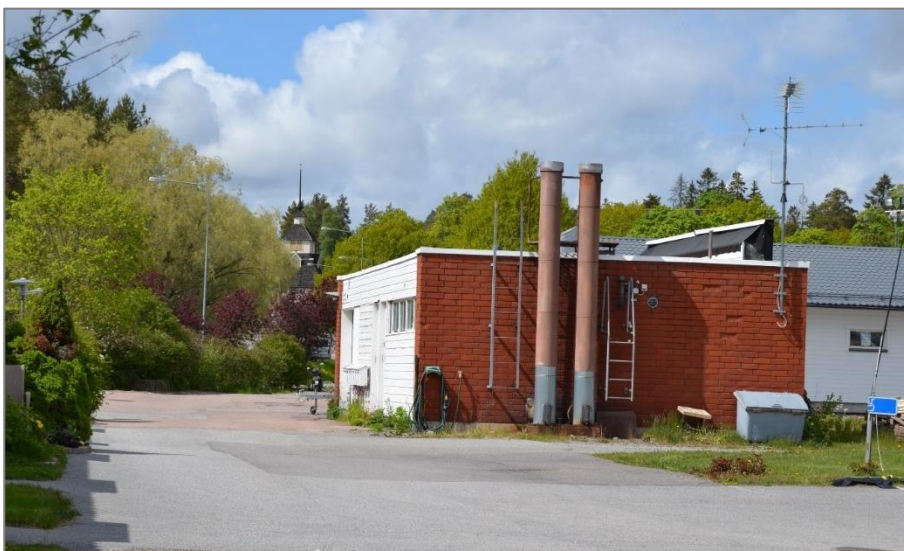
Kuva 52. Rivitalopihan luoteissivulla sijaitseva huoltorakennus tehtiin alun perin päiväkotirakennuksen yhteyteen. Päiväkoti sijoittui kuvassa huoltorakennuksen taakse. Taustalla näkyy Maskun kirkon tapuli.
