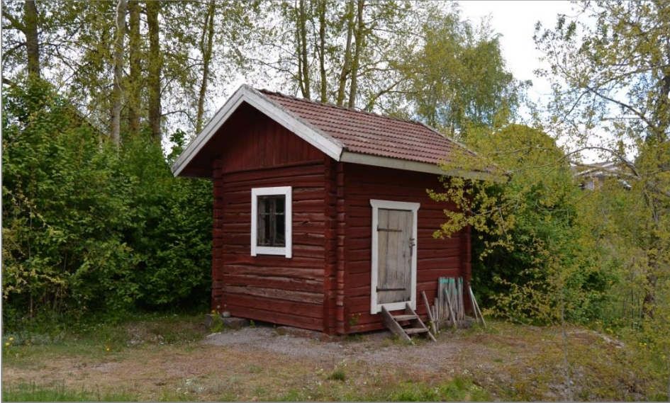
Kuva 38. Entinen maituhuone kuvattuna kaakosta.
