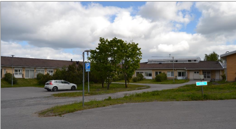
Kuva 53. Palvelukeskuksen länsipuolta. Oikeassa reunassa näkyy ensimmäisen rakennusvaiheen päätyä. Vasemmassa reunassa on B-siipi (rakennusvaihe V) vuodelta 1998. Keskellä sijaitsee vaihe IV vuodelta 1995.
