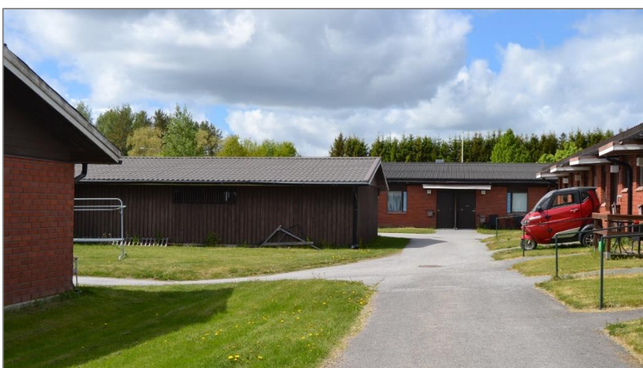
Kuva 50. Rivitalopihaa kuvattuna Nivolantieltä, kuvaussuunta luoteeseen. Pihan varastorakennusta on laajennettu vuonna 2003. (MAS.)
