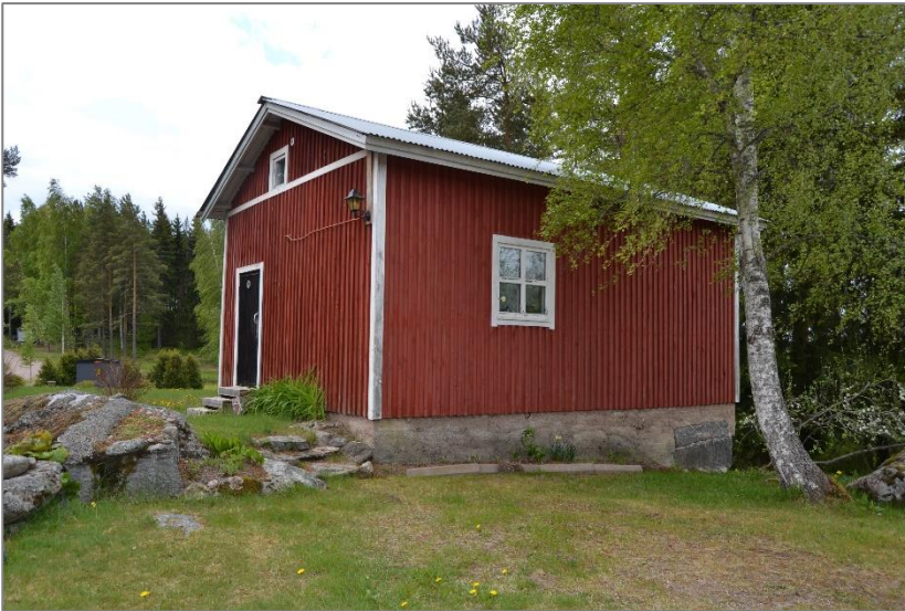
Kuva 26. Rinteeseen rakennetun piharakennuksen korkea lohkokivisokkeli on betonoitu. Rakennuksessa on aaltopeltikate.
