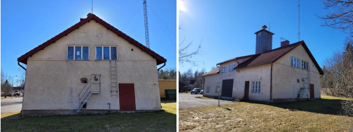
Kuva 9 Vanhan paloaseman pohjoispääty (vasemmalla) sekä pohjoispääty ja itäjulkisivu (oikealla).
