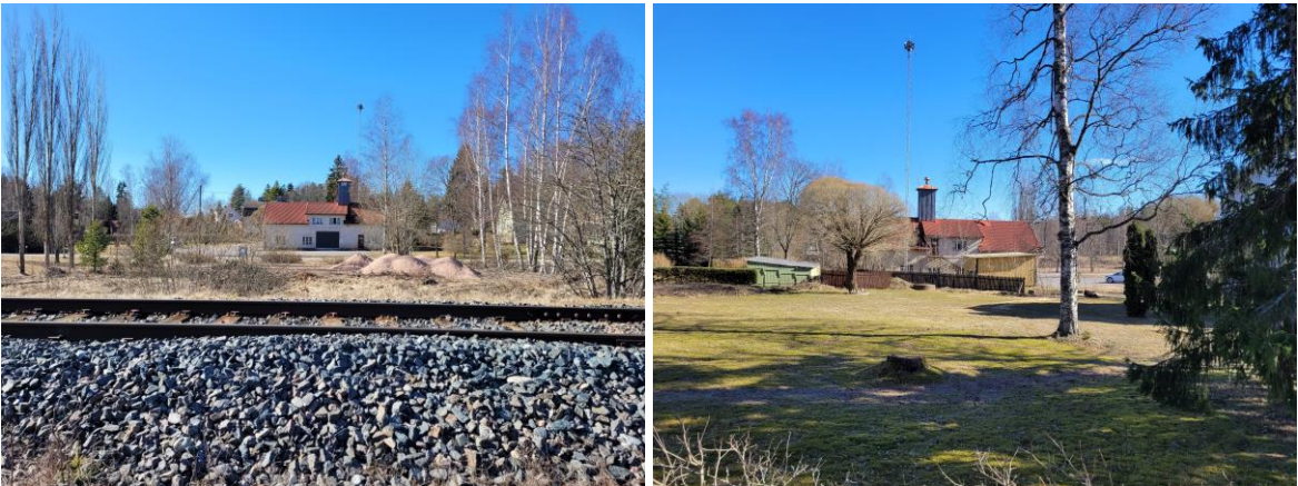
Kuva 4 Vanha paloasema näkyy junaradan yli sen itäpuolelle Tapulitielle (vasemmalla) sekä pihapiirien välistä Heikkiläntielle (oikealla).
