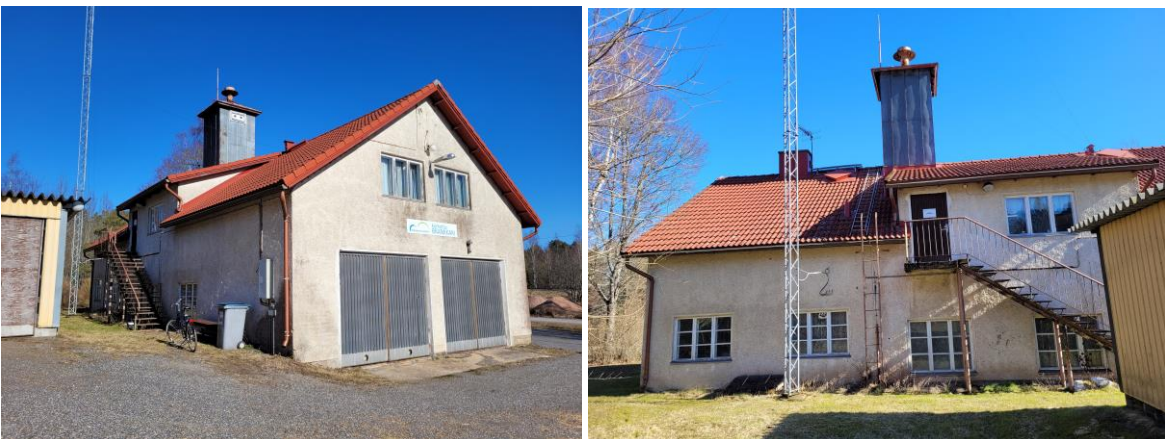
Kuva 8 Rakennuksen eteläpääty ja länsijulkisivu (vasemmalla) sekä länsijulkisivun pohjoisosa (oikealla).
