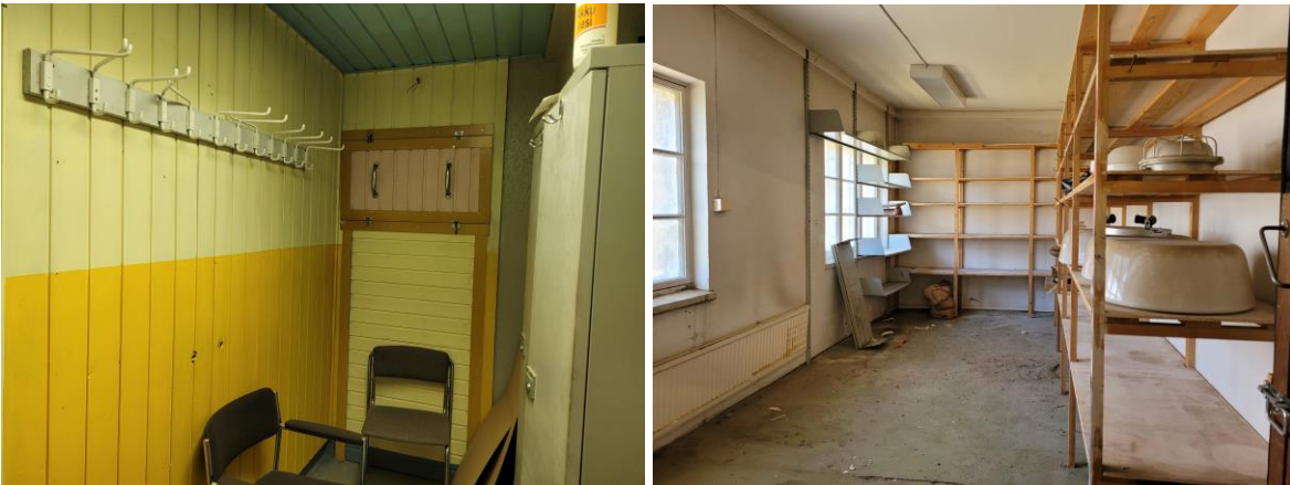
Kuva 15 Pukuhuoneesta on käynti pannuhuoneeseen (vasemmalla). Pukuhuoneen ja pannuhuoneen länsipuolella on pienempi varastotila (oikealla).
