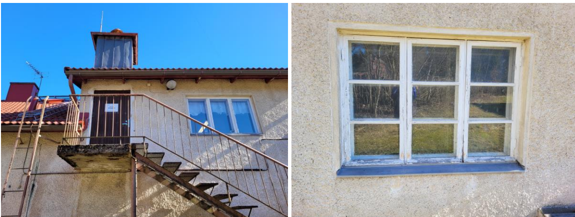
Kuva 10 Rakennuksen toiseen kerrokseen pääsee länsijulkisivulla olevia portaita pitkin (vasemmalla). Yhdeksänruutuiset ikkunat ovat todennäköisesti alkuperäiset (oikealla).
