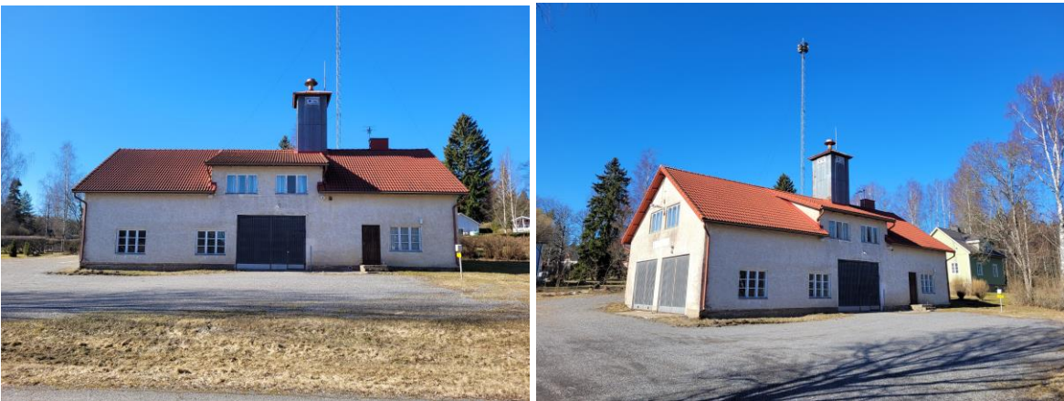
Kuva 7 Vanhan paloaseman itäjulkisivu (vasemmalla) sekä eteläpääty ja itäjulkisivu (oikealla) Paloasemantieltä katsottuna.
