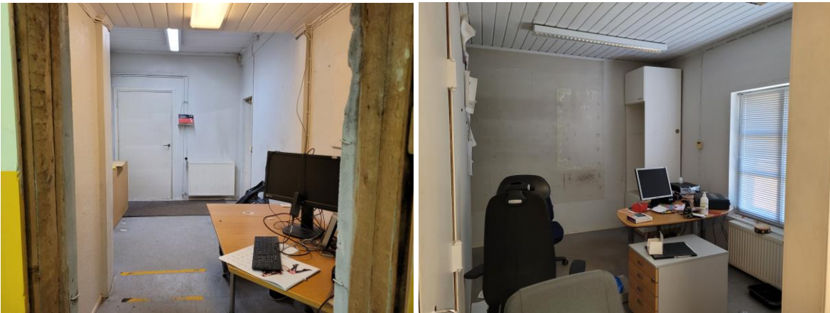
Kuva 14 Näkymä pukuhuoneen ovelta kohti eteistä (vasemmalla) ja eteisen vieressä sijaitseva toimistohuone (oikealla).
