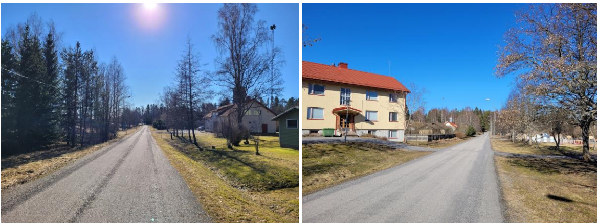
Kuva 5 Paloasemantien pohjoispäädystä (vasemmalla) ja eteläpäädystä (oikealla) näkymä kohti vanhaa paloasemaa. Pohjoisesta rakennus näkyy kokonaisuudessaan tien laidalla ja etelässä muiden rakennusten takaa näkyy vähän aseman päätyä sekä sen korkea torni.
