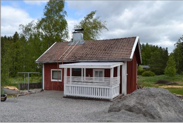
Kuva 24. Sauna sijaitsee asuinrakennusta vastapäätä. Rakennuksessa on tiilikate.
