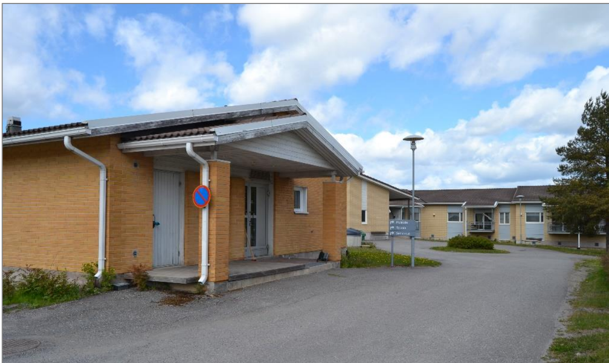
Kuva 60. Palvelukeskuksen itäisivua. Kuvassa vasemmalla vaiheen III pääty. Taustalla näkyy vaiheessa VI valmistunut rakennusosa.
