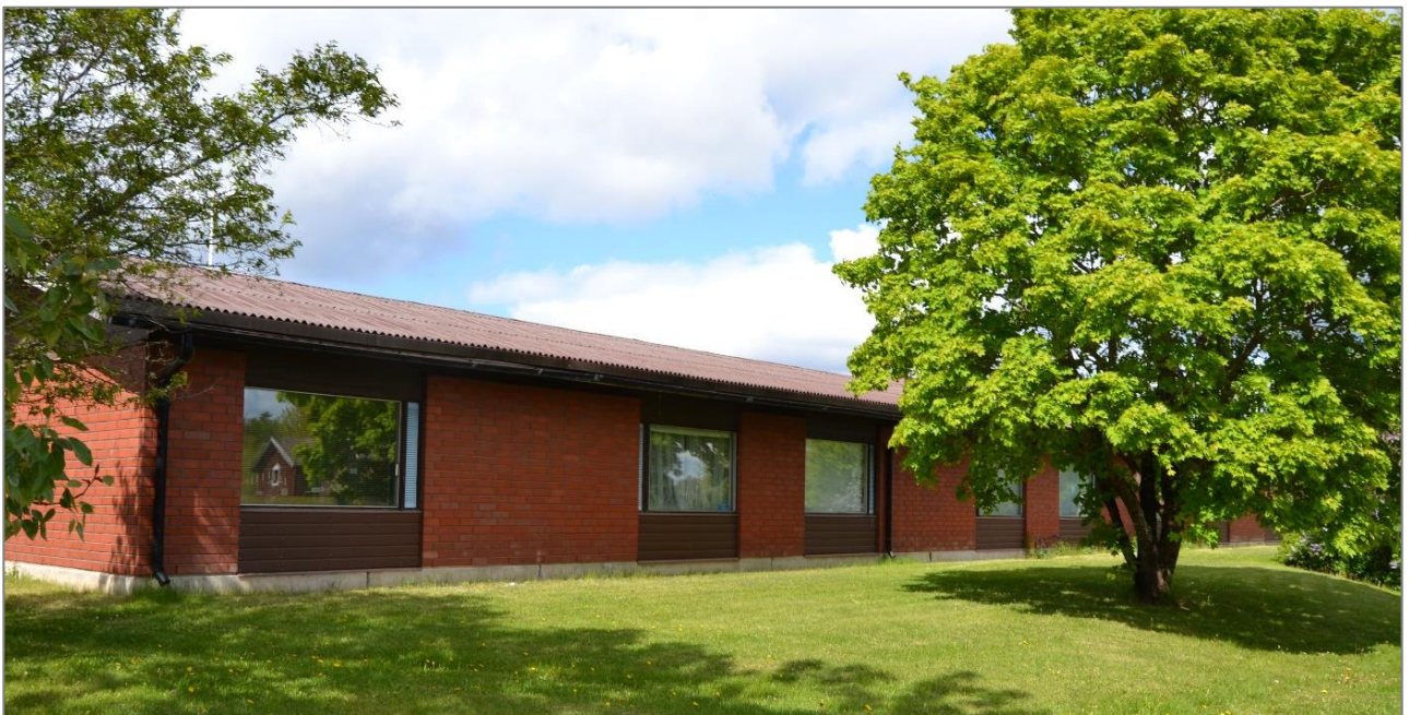
Kuva 52. Vanhusten asuinrivitalo kuvattuna Nivolantieltä, kuvaussuunta pohjoiseen.
