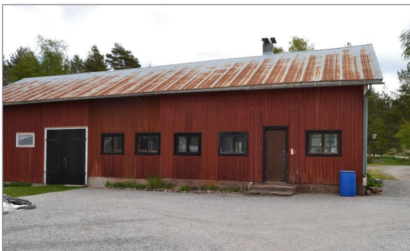
Kuva 21. Varasto- ja hallirakennuksen alkuperäisen osan, kuvassa oikealla, sokkeli on lohkokiveä. Rakennuksen katteena on aaltopelti.
