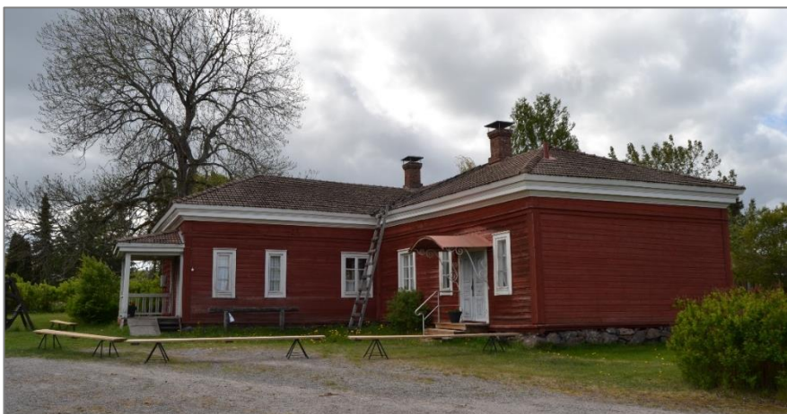
Kuva 36. Palsalan päärakennus kuvattuna koillisesta.
