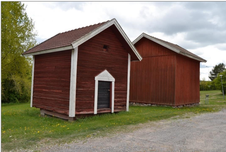
Kuva 40. Pohjoisimpana sijaitsevassa aitassa on puusokkeli.
