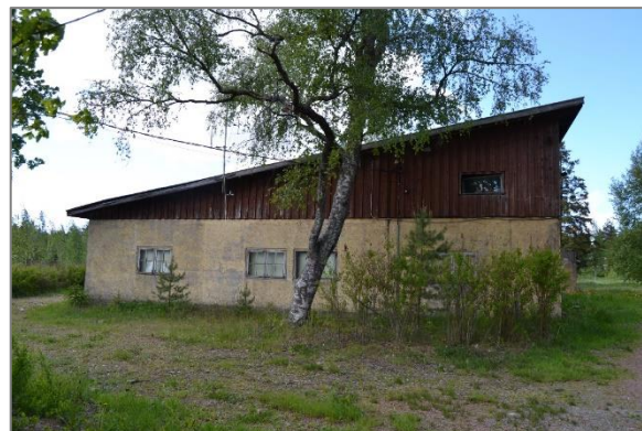
Kuva 49. Navettarakennuksen pääty kuvattuna idästä Kankaistentieltä.
