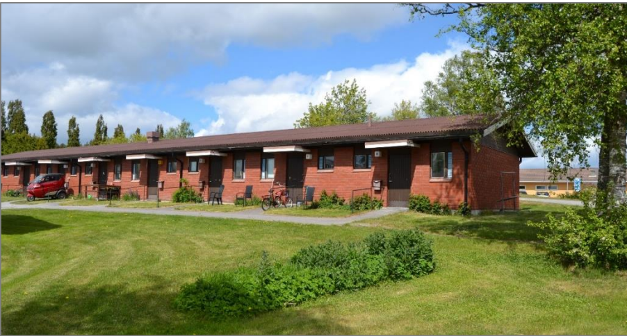
Kuva 54. Rivitalopihaa kuvattuna Nivolantieltä, kuvaussuunta pohjoiseen. Taustalla oikealla näkyy Luukan palvelukeskus.
