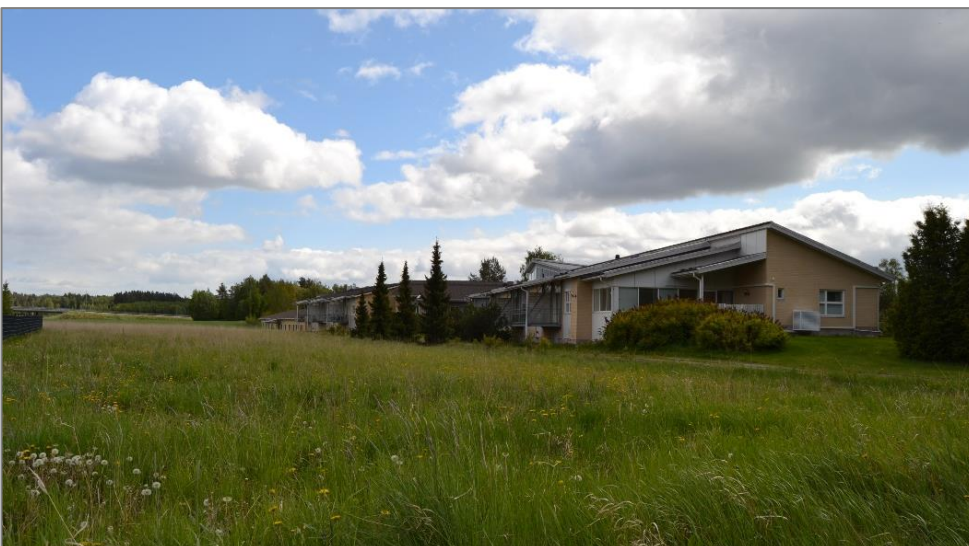
Kuva 58. Kuvassa lähimpänä rakennusvaihe V:n eli ns. B-siiven pääty. Kuvaussuunta kaakkoon. Palvelukeskus sijaitsee laajan peltoaukean laidalla.
