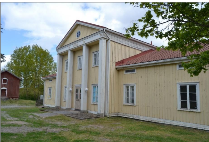
Kuva 33. Nivolan pääjulkisivua lännen puolelta. Ulkonevan poikkipäädyn pylväävät ovat hieman erillään seinästä.
